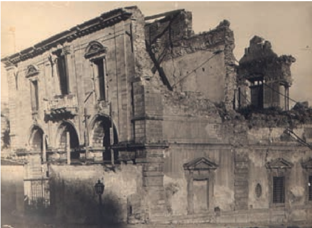
Messina - Monte di Pietà . Prospetti sul cortile interno e laterale sud dopo il terremoto del 1908. Foto: autore ignoto.
