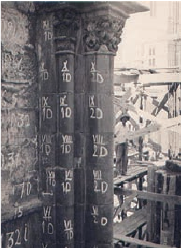
Messina - Chiesa di Santa Maria Alemanna . Numerazione dei conci per lo smontaggio e rimontaggio durante i restauri del 1941. Foto: autore ignoto.
